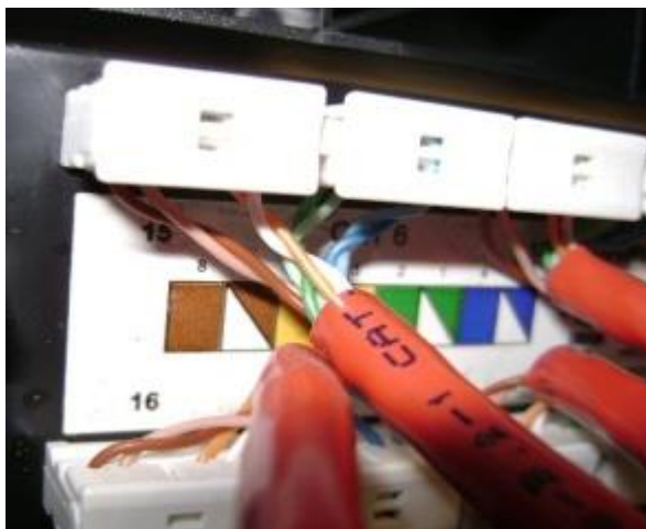
Exemplo de boa execução de conectorização.
